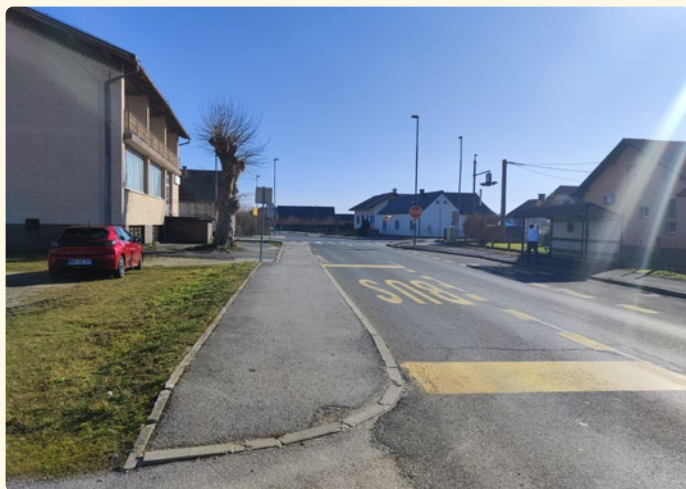
Slika 29: Označeno in registrirano avtobusno postajališče v Srednji Bistrici pri križišču z državno cesto – na eni strani z nišo, na drugi strani s horizontalno oznako na cestišču
