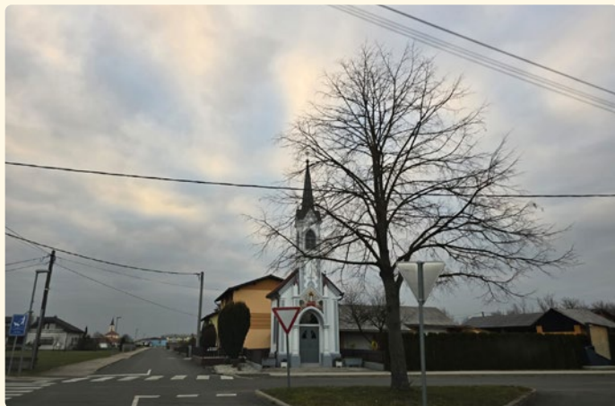
Slika 38: Y-križišče v strnjenem naselju Žižki, kjer trenutna ureditev ustvarja več konfliktnih točk in zmanjšuje preglednost za udeležence v prometu
