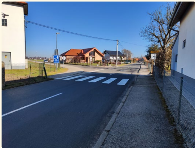
Slika 13: Prehod za pešce pred križiščem – ustrezno talno označen, vendar brez opozorilnega znaka, kar zmanjšuje prepoznavnost prehoda za voznike in varnost pešcev
